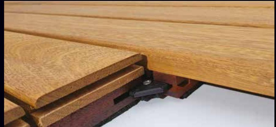
Les modules seront posés par rangée l'un après l'autre et positionnés grâce à l'aboutage (mâle/femelle) au bout des lames de terrasse.
